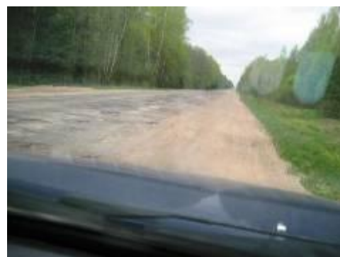
Рис. 1.137. Когда площадь глубоких выбоин и ям превышает площадь асфальта, приходится ехать по обочине. Слева – не сельская дорога в глубинке, а федеральное шоссе А101, соединяющее Москву с братской Беларусью. Всего 200 км от Москвы, май 2008 г.
